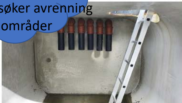
Innløp sett innenfra
