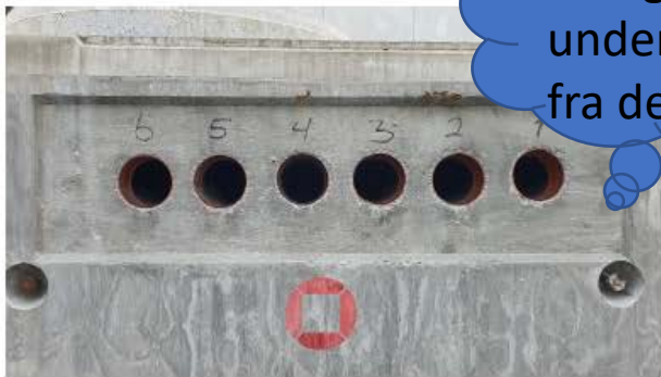
Innløp sett utenfra
