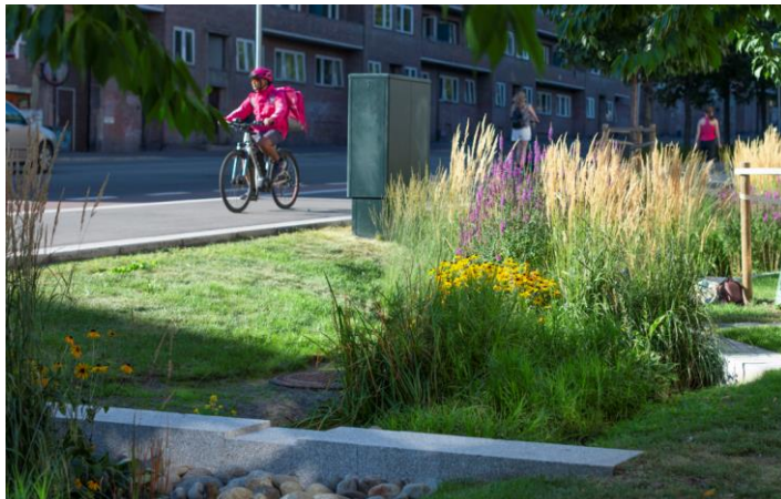
Regnbed i Maridalsveien (Foto: Oda Fjellang)
