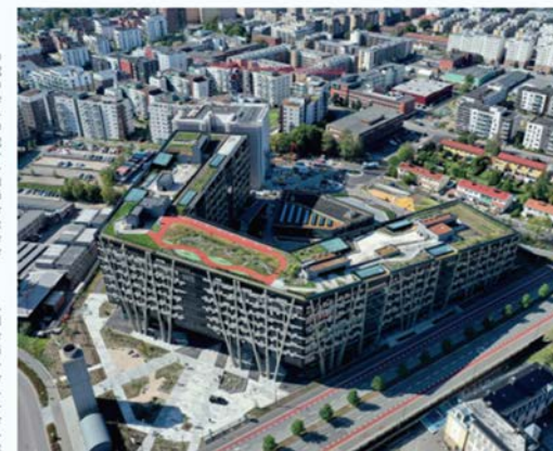
Taket på Kikern Park er et godt eksempel på hvordan takarealer kan erstatte areal på bakkenivå. Foto: Christian Ganvold Hansen.
