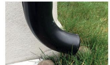
Bilde 1: Frakobling av taknedløp kaster vannet ut på plenen og reduserer muligheten for oversvømmelse av kjeller.
